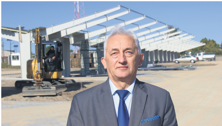
Tadeusz Kruszyński, przewodniczący Rady Gminy Sulmierzyce na placu budowy
