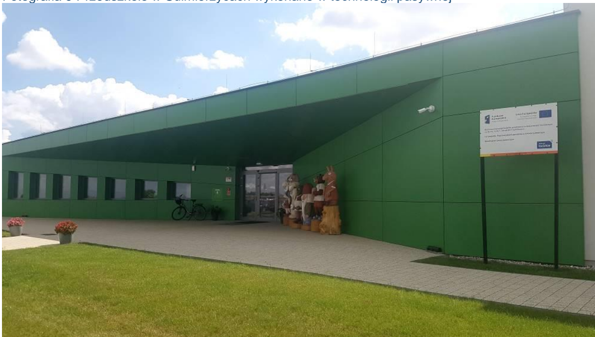
Fotografia 9 Przedszkole w Sulmierzycach wykonane w technologii pasywnej
